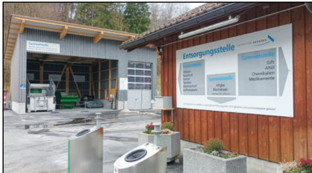
3. Januar: Dank der neuen Halle können viele Bereiche der Entsorgungsstelle nun auch ausserhalb der eigentlichen Öffnungszeiten genutzt werden. Bild Heini Schwendener
