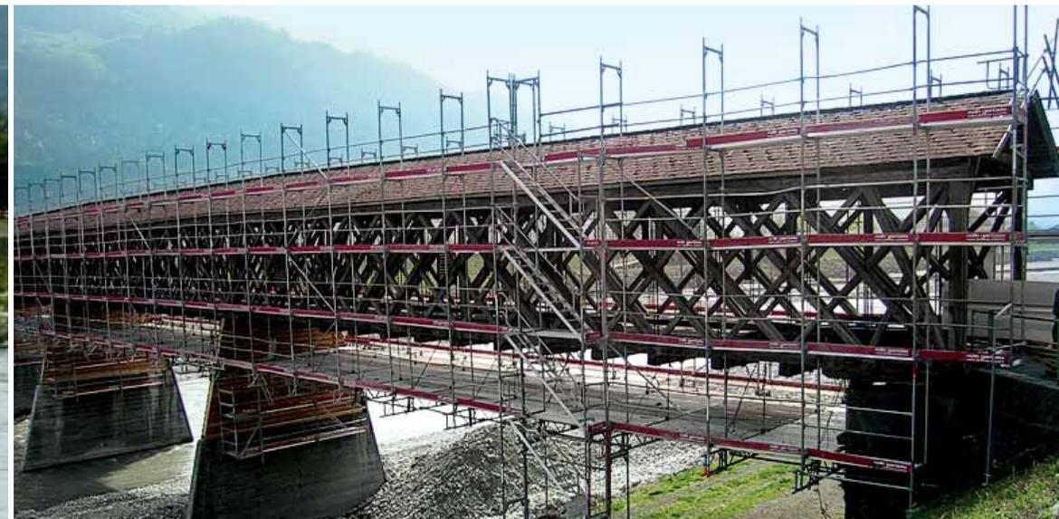
So wurden am gut erhaltenen Fachwerk nur einzelne Teile ersetzt oder sogar nur lokale Massnahmen wie Teilersatz von kleinen verfaulten Stellen oder Abdecken von angegriffenen Oberflächen, etc. vorgenommen.
